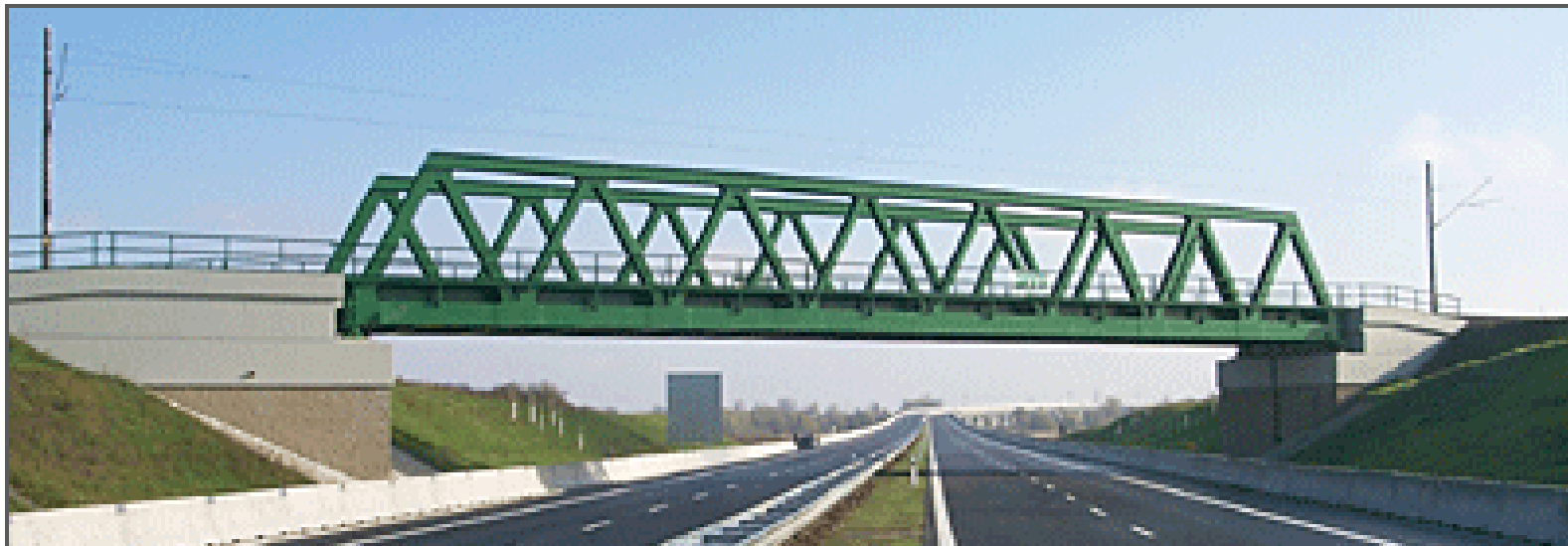
Železniční příhradový most na trati Plesná, st. hranice – Cheb, 1998
