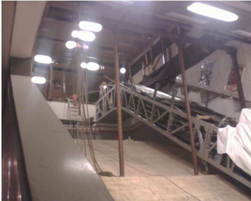
Nosná konstrukce eskalátoru metra, Dejvická
