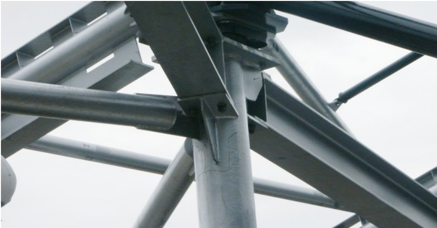
Detail styčnicku zastřešení haly Sazka, Praha, foto: autor
