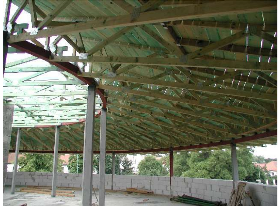
Střešní vazníky, materiál Střediska výroby vazníků v Brně
