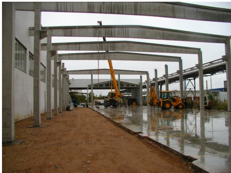
Železobetonová hala, SAPA-LPJ
