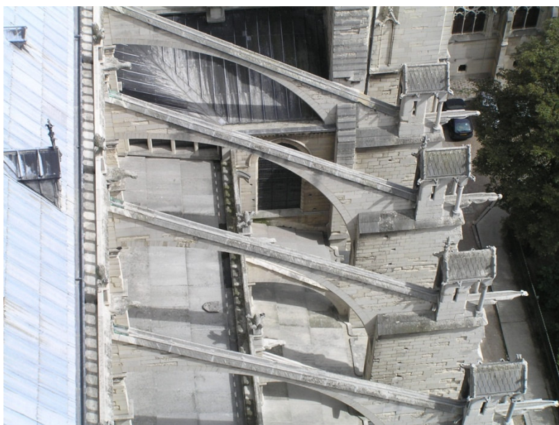
Obr. 6.6 – Paříž, katedrála Notre-Dame, opěrný systém lodí
