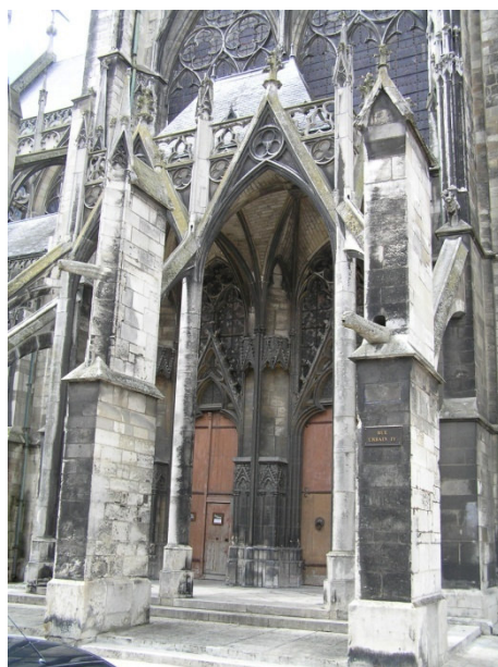
Obr. 6.15 – Troyes, bazilika sv. Urbana, předsín s opěrným systémem
