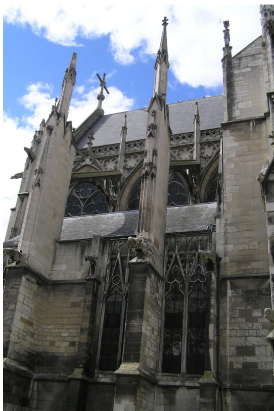
Obr. 6.16 – Troyes, bazilika sv. Urbana, opěrný oblouk (převzato z [8])
