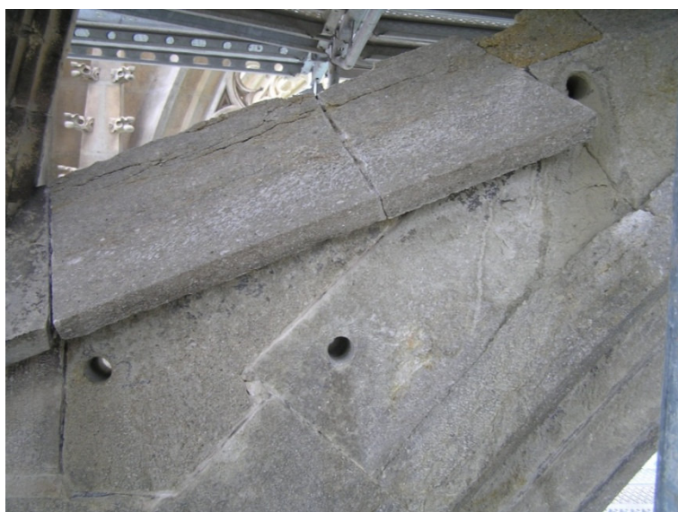
Obr. 8.4 - Chrám sv. Barbory v Kutné Hoře, dolní opěrný oblouk OsLS6 po odběru vzorků
