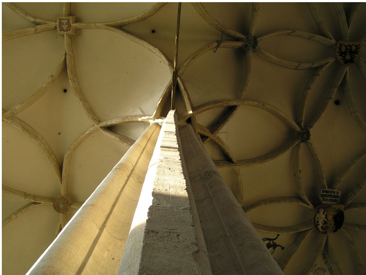
Obr. 11.19 – Prohnutí pilíře směrem nad jižní tribunu v pozici C2
