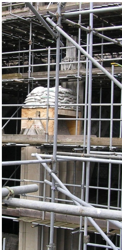
Obr. 6.21 – St.- Hertogenbosch, katedrála sv. Jana, přitížení opěrného pilíře pytlí s pískem při výměně fiály
