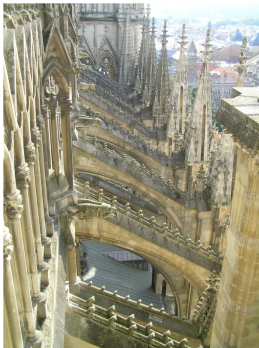
Obr. 6.11 - Remeš, katedrála Notre-Dame, pohled shora na opěrný systém lodi
