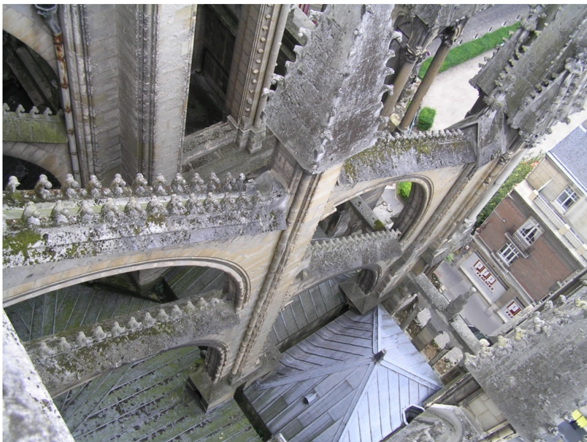
Obr. 5.7- Remeš, katedrála Notre-Dame, opěrný systém vysokého chóru, severní strana při věži křížení
