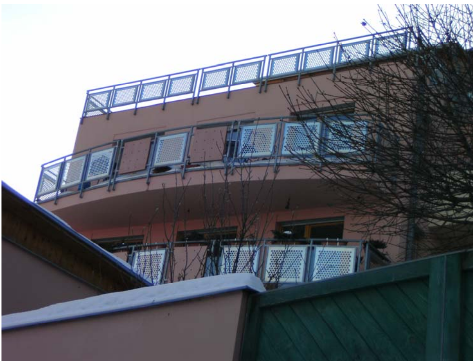
Pohled na severní fasádu se zaobleným balkónem
