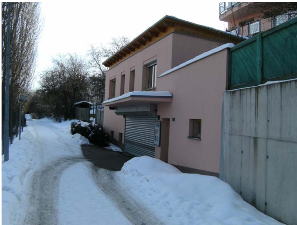
Severní strana objektu, vjezd do garáží
