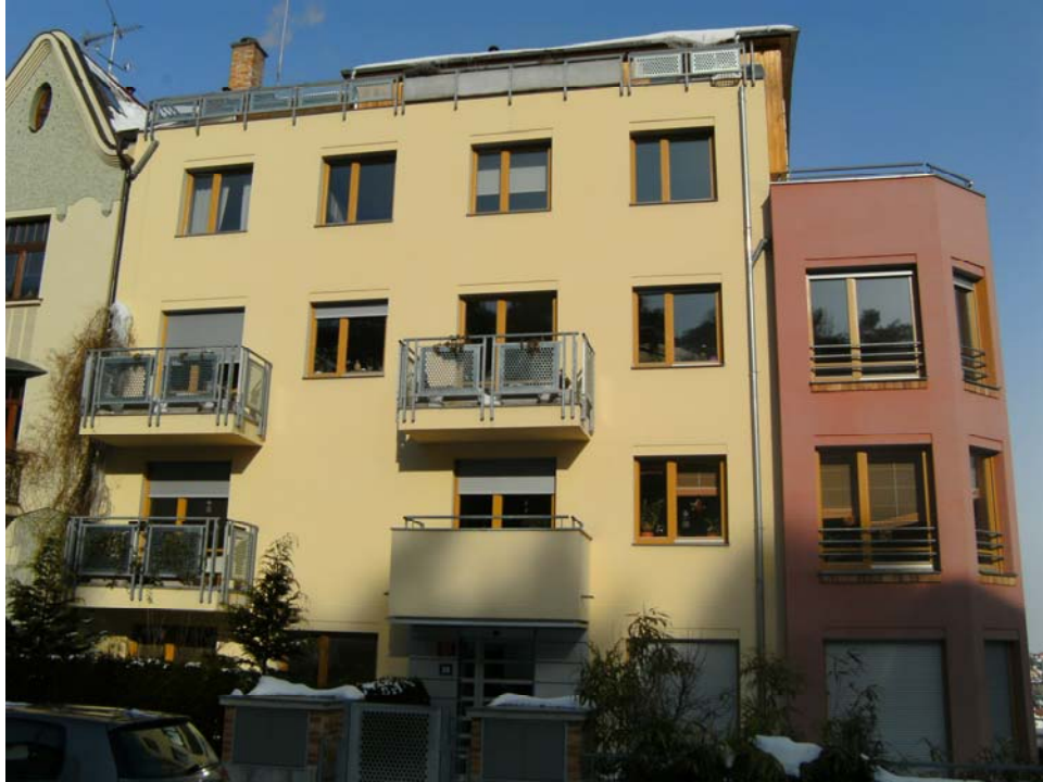
Pohled na jižní fasádu
