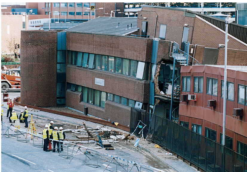
Obrázek 1: Poškození budov během ražby tunelu Heathrow [19]
