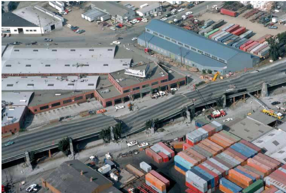
Obrázek 31: Letecký pohled na poničený Cypress viadukt, Oakland, Kalifornie (zdroj: usgs.gov)
