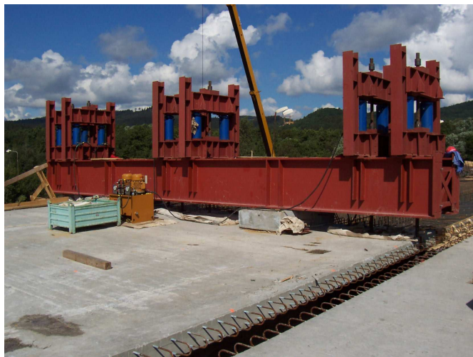
Obrázek 4.3.8: Přesuvná skruž - pohled na umístění lisu na mostní konstrukci.
