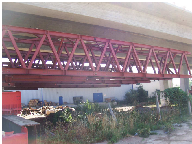
Obrázek 4.3.6: Přesuvná skruž - pohled na výsuvný nos.
