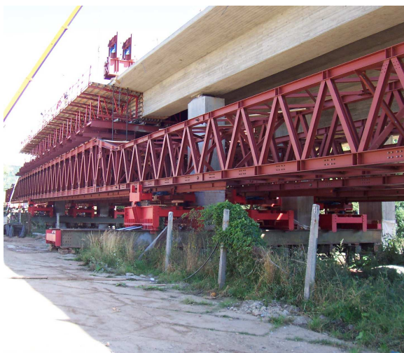
Obrázek 4.3.4: Přesuvná skruž - pohled na konstrukci.
