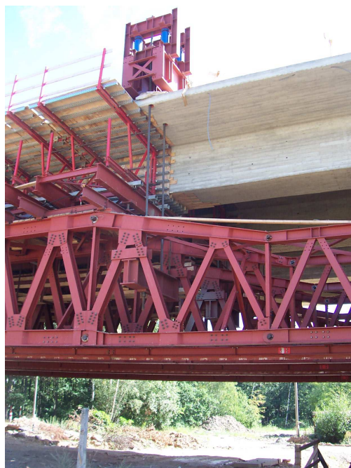
Obrázek 4.3.7: Přesuvná skruž - pohled na redukci a závěsné tyče.
