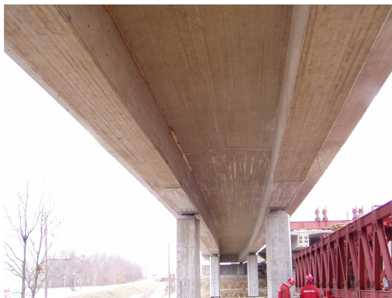
Obrázek 4.2.5: Dolní pohled na mostní konstrukci.
