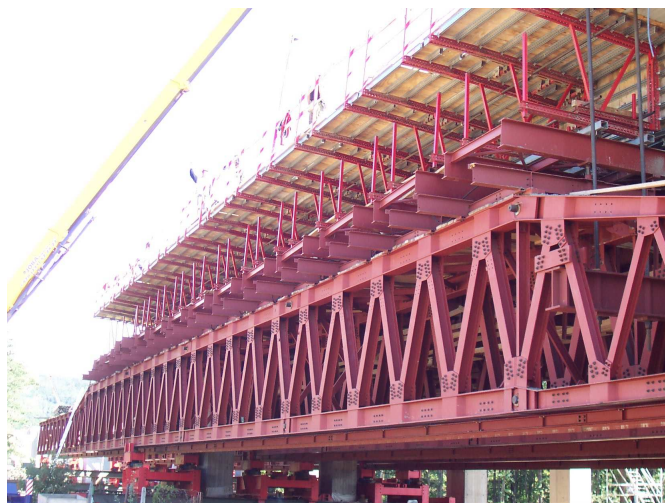
Obrázek 4.3.5: Přesuvná skruž - pohled na hlavní nosník.
