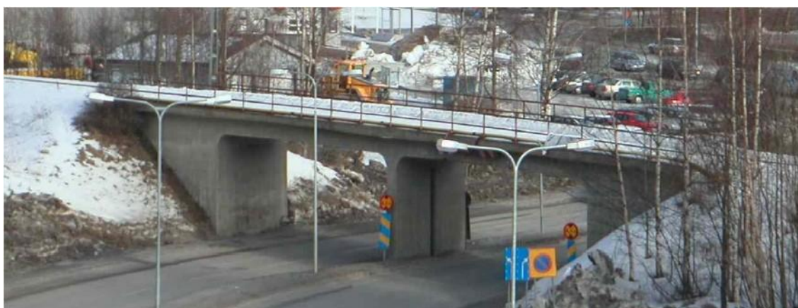
obr. 3.1: Železobetonový most v Örnköldsviku
