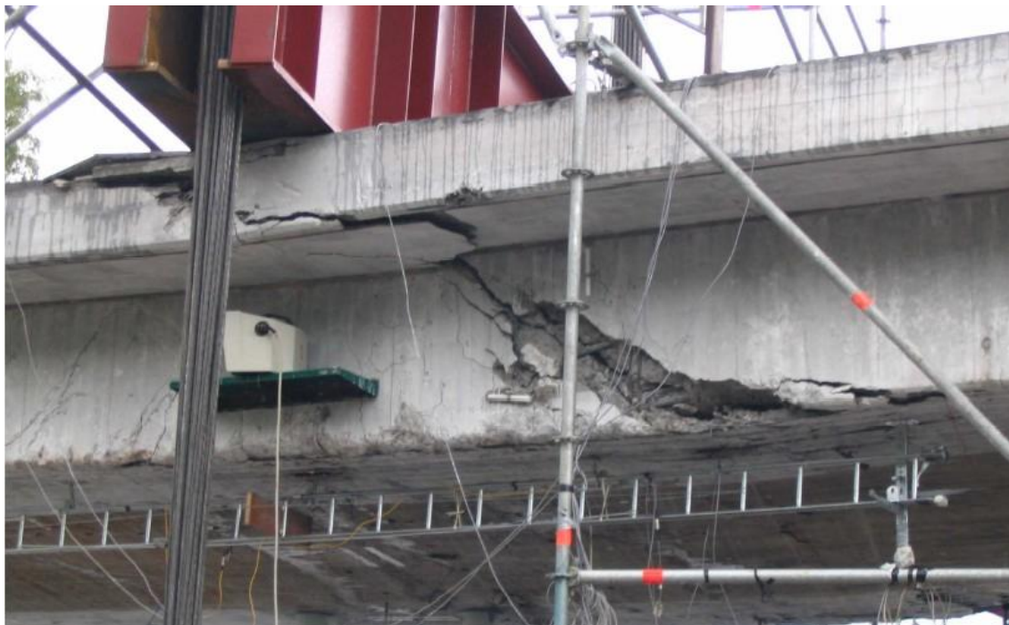
obr. 3.24: Porovnání experimentu s počítačovým modelem – reálná konstrukce
