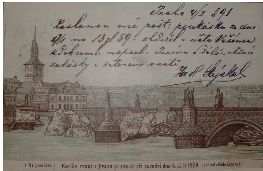
obr. 2.1: Karlův most po povodni roku 1890
