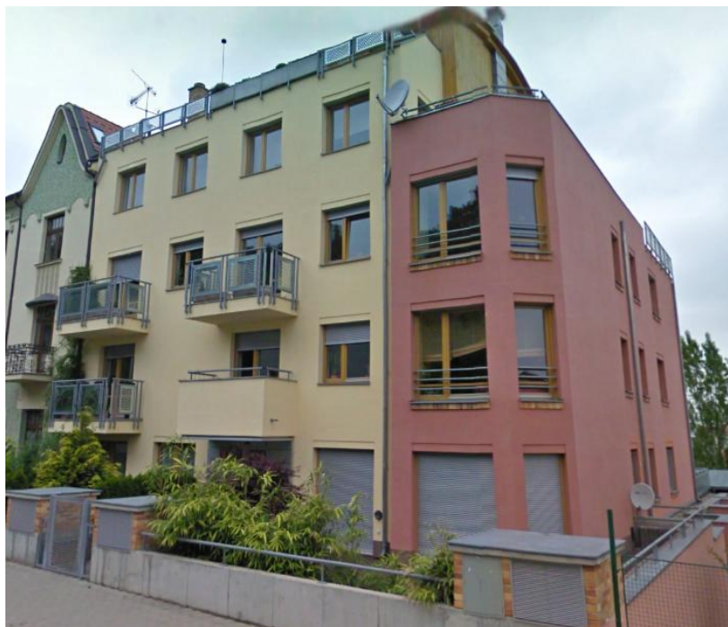
Obr. 3-1: Pohled na jižní fasádu obytného domu
