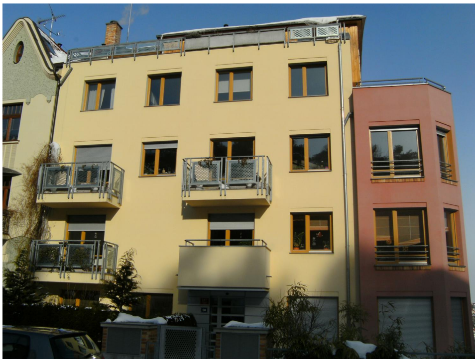
Pohled na jižní fasádu
