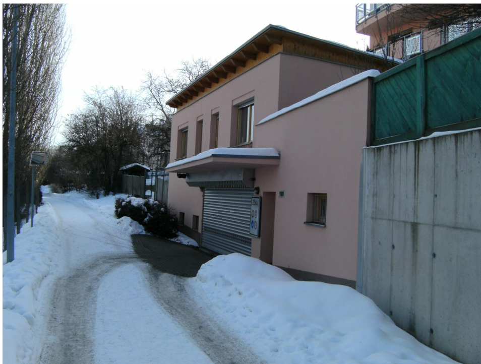
Severní strana objektu, vjezd do garáží
