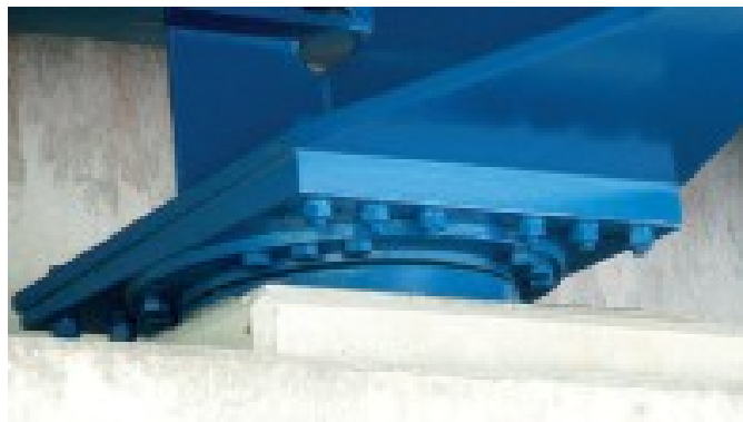
Pevné hrncové ložisko
