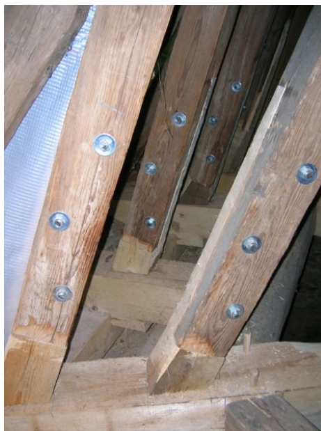
Uložení krokví foto: autor
