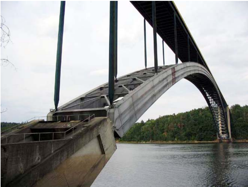
Žďákovský most, rozpětí ocelového oblouku 330 m (3100 t), vzepětí 42,5 m, 1967
