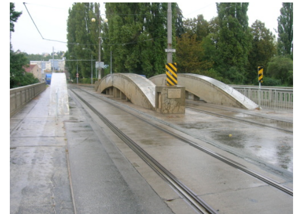
Maloměřický most s mezilehlou mostovkou, Brno, tři paralelní trojkloubové oblouky, rozpětí 33 m, 1928
