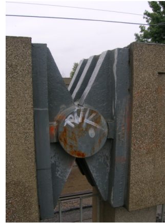
Maloměřický most s mezilehlou mostovkou, Brno, tři paralelní trojkloubové oblouky, rozpětí 33 m, 1928
