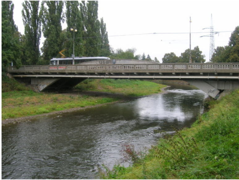
Maloměřický most s mezilehlou mostovkou, Brno, tři paralelní trojkloubové oblouky, rozpětí 33 m, 1928
